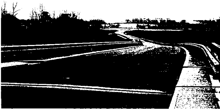
13 - Depuis le pont sur l'autoroute
