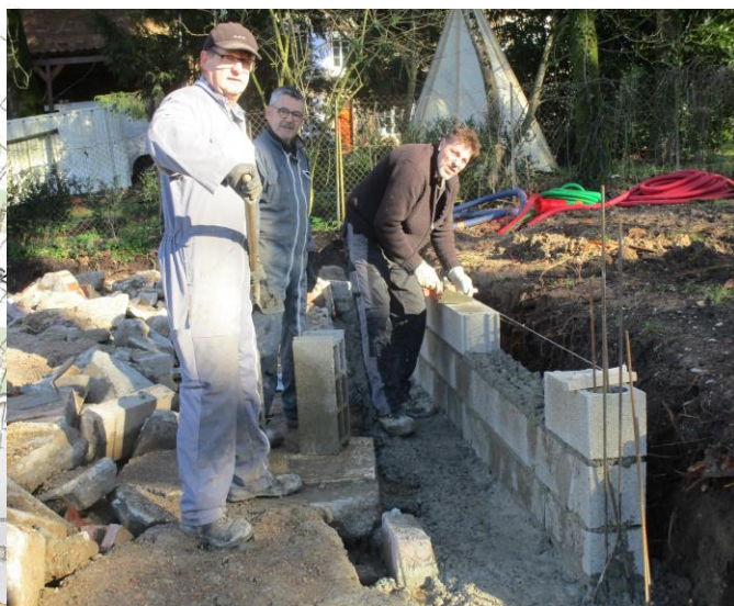
Nos employés lors des travaux du parking
